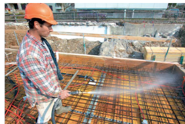
Vornässen von Bewehrung und Schalung
