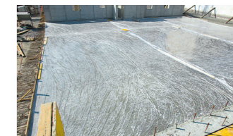
Abdecken einer Betondecke mit Kunststoffolie
