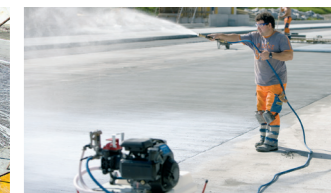
Aufsprühen eines Nachbehandlungsmittels
